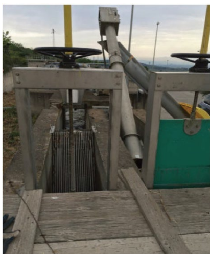
Figura 28 Canale di by-pass con grigliatura.
