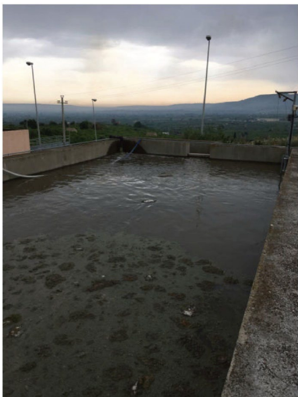
Figura 30 Vasca di pre-denitrificazione Linea 2.
