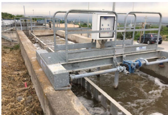
Figura 29 Unità di dissabbiatura-disoleatura.
