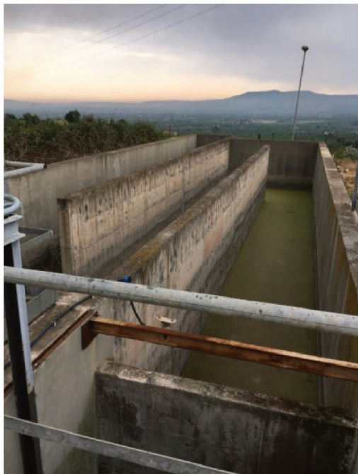
Figura 32 Labirinto di clorazione.
