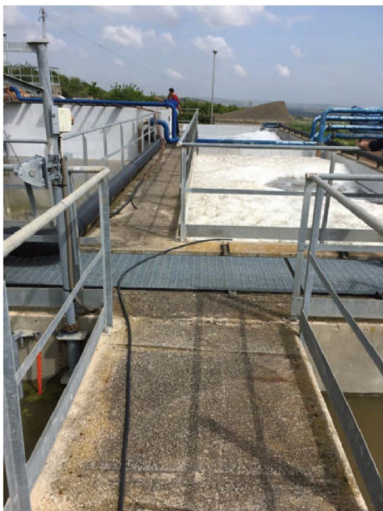
Figura 31 Vasche di ossidazione-nitrificazione.
